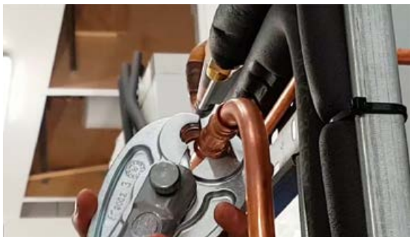
De installatie werd uitgevoerd met Zoomlock, een eenvoudige methode om sneller en efficiënter te monteren. (foto Frigo)
